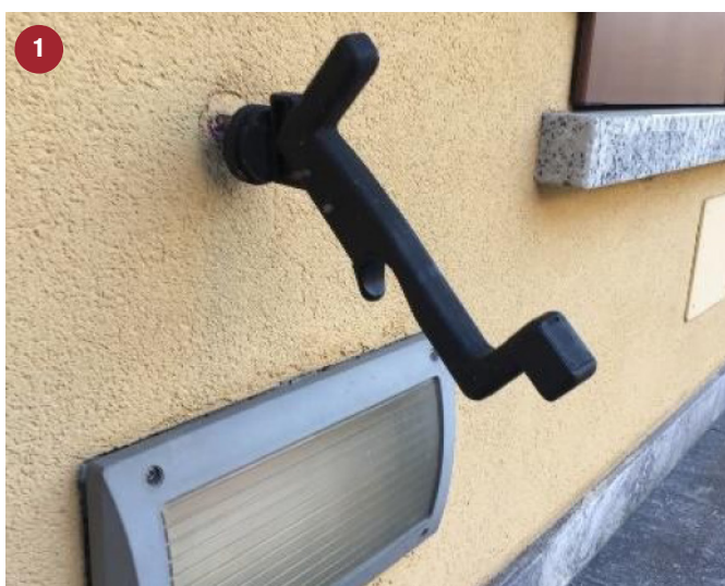
1. Cedimento del fermascuro avvitato direttamente nell'isolante.
