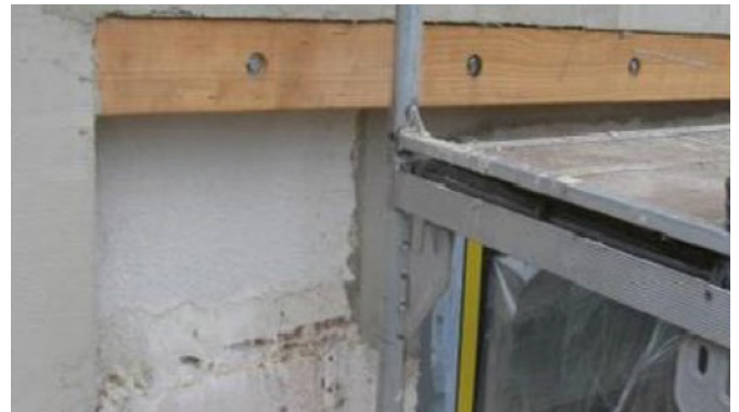
5. Soluzione fai da te con blocchetto in legno. La prestazione meccanica non è costante nel tempo.
