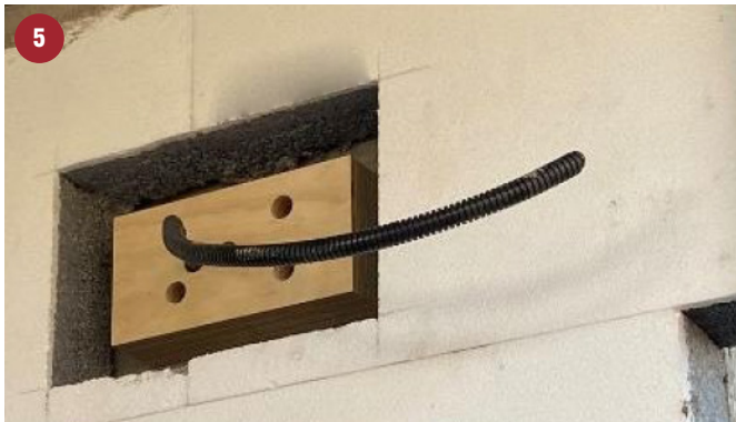
5. Soluzione fai da te con blocchetto in legno. La prestazione meccanica non è costante nel tempo.
