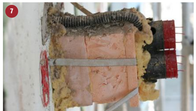
7. Cassetta elettrica fissata con staffette in acciaio. Ponte termico e rischio elettrico.
