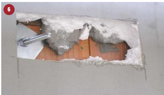
6. Soluzione fai da te con staffa in acciaio. Nonostante la buona prestazione meccanica, si forma inevitabilmente un ponte termico.
